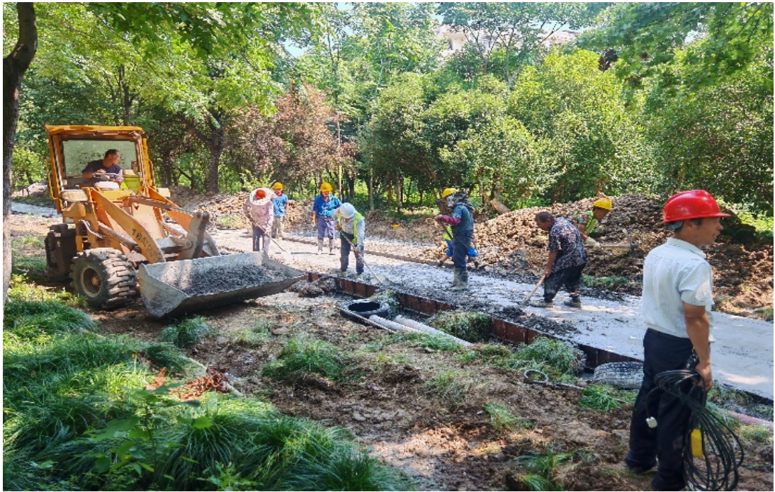
东侧新健身小路施工现场
