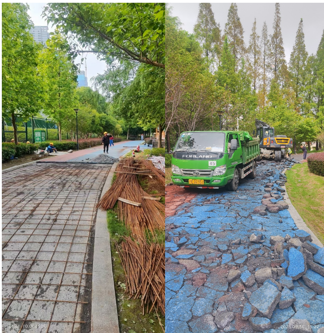
对原开裂拱起的健身步道进行修复
