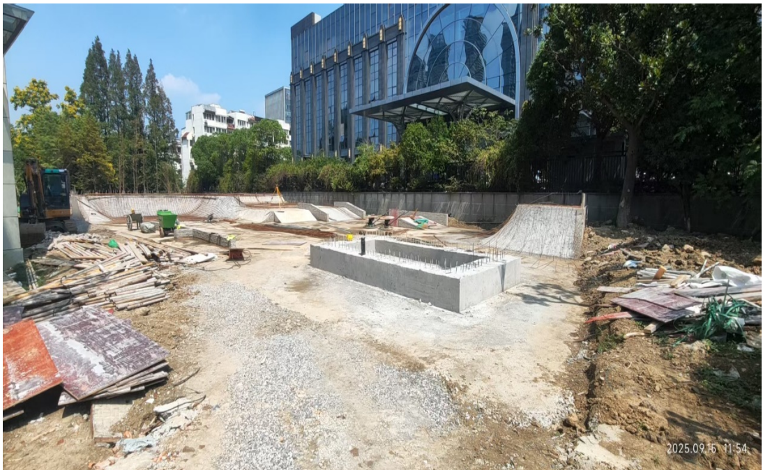
新建轮滑球场、滑板场施工现场
